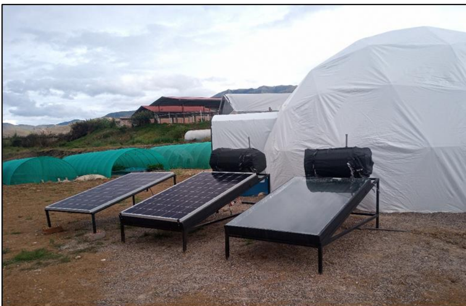
Figura S2. Instalación de los sistemas (FV, FVT y ST)
