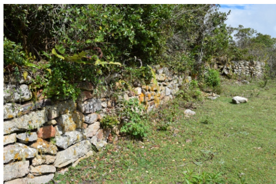
Figura 01. Muro de contención sinuosa en el nivel bajo del sitio Huanca Urco.
